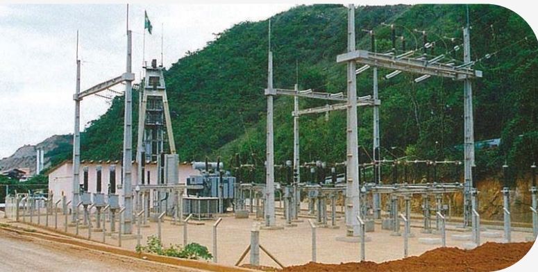
Votorantim - Vazante -MG Obras Civis da Subestação S.E. 12MVA, 138 KV
