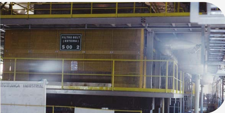
Votorantim - Três Marias -MG Obras Civis e Montagem Eletromecânica da Instalação do Filtro de Correias
