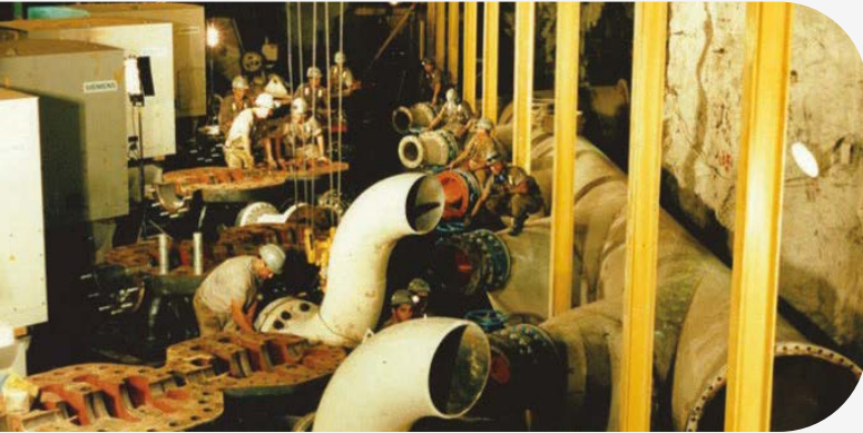
Votorantim - Vazante -MG Obras Civis , obra de comporta em mina subterrânea
